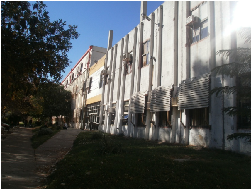
Fig. 1. Edificio Principal Campus Universitario FICA-FACEJS
