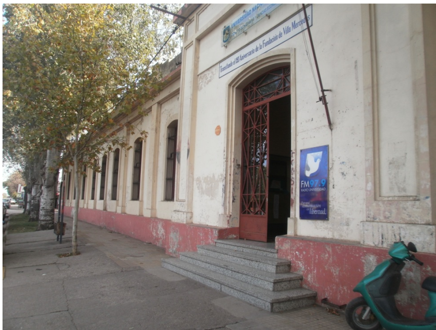
Fig. 4. Edificio 25 de Mayo.
