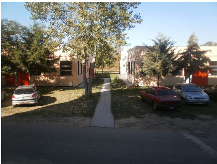
Fig. 2. Edificios de Química (Campus Universitario).
