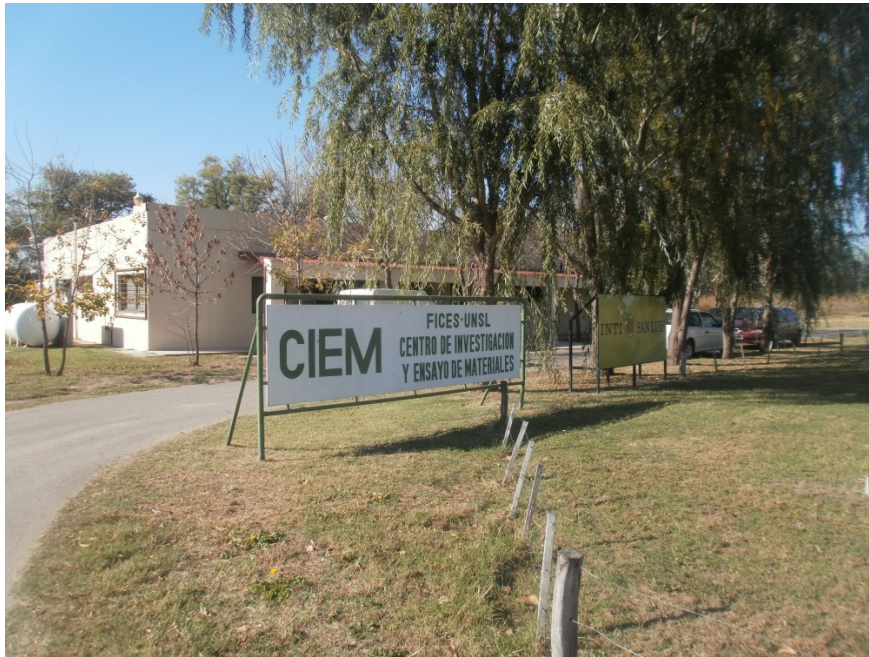
Fig. 3. Edificios CIEM-INTI (Campus Universitario).
